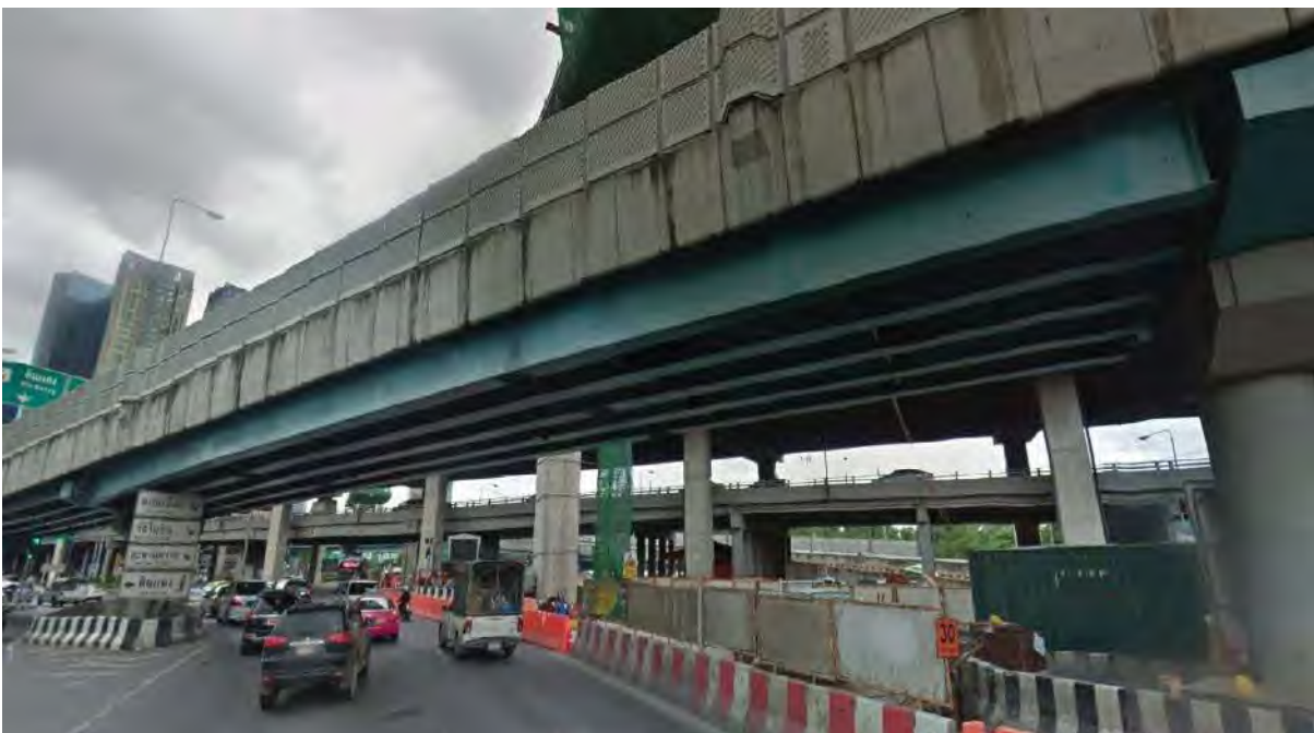
รูปที่ 5.1-3 สะพานตัวที่ 3 (Flyover 3) ช่วงสะพานที่ 7 (Span 7) และช่วงสะพานที่ 8 (Span 8)
