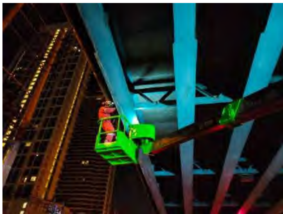
รูปที่ 4.1-12 การตรวจสอบความสมบูรณ์ของรอยเชื่อมด้วยวิธี Eddy Current
