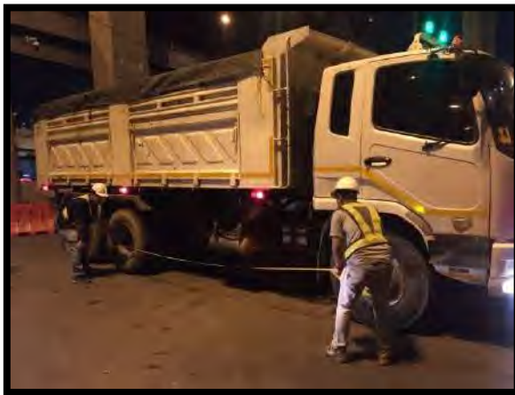
รูปที่ 5.8-4 ภาพการวัดมิติของรถบรรทุก
