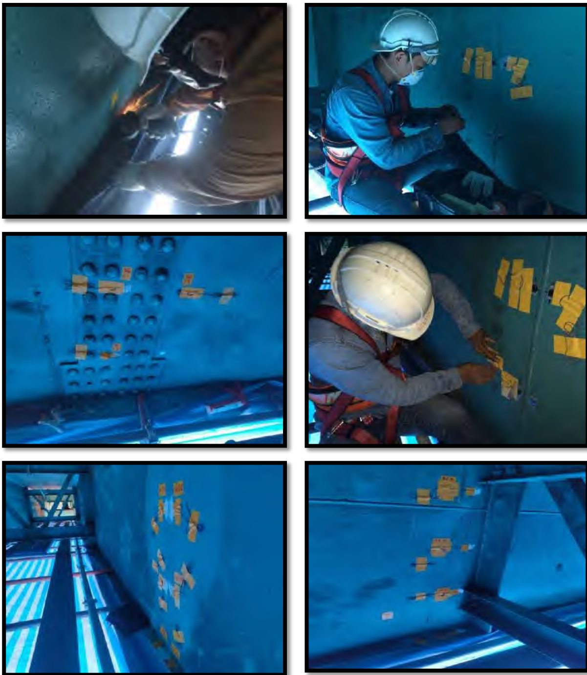
รูปที่ 5.8-3 ภาพการติดตั้งอุปกรณ์ตรวจวัดสะพานตัวที่ 2 (Flyover 2)
