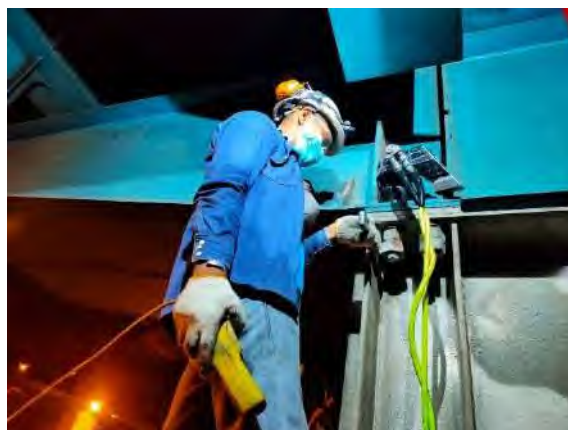
รูปที่ 4.3-8 การตรวจสอบความสมบูรณ์ของสลักเกลียวด้วยวิธี Torque Examination
