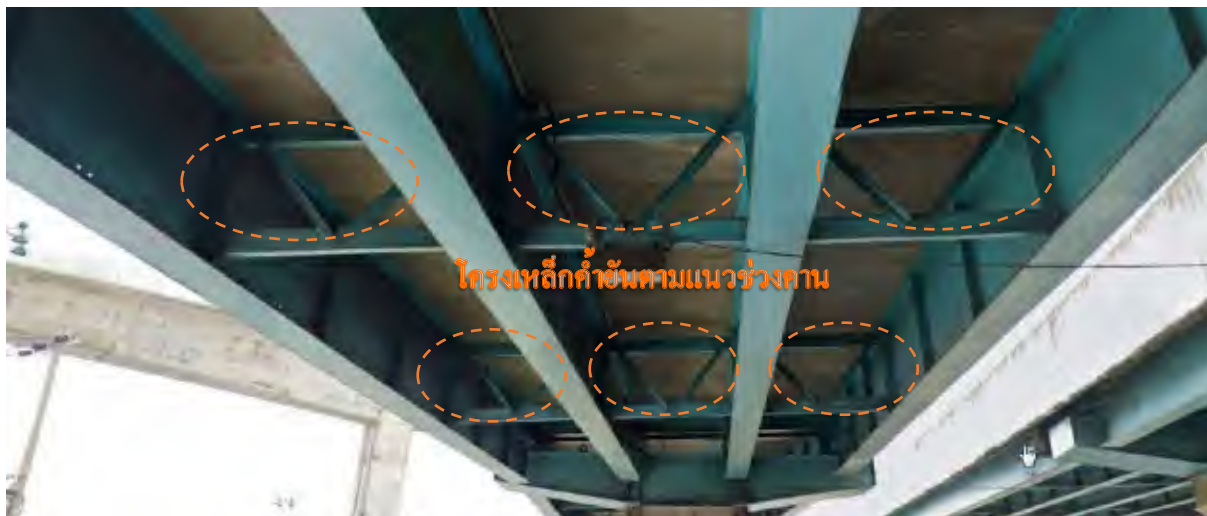
รูปที่ 10.2-3 (ต่อ) ค้ำยันคานสะพาน
