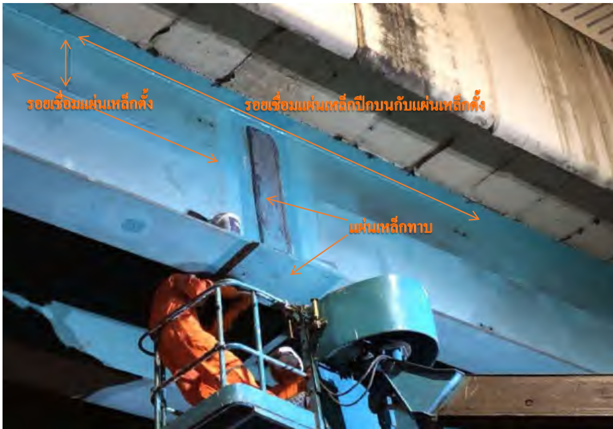
รูปที่ 10.2-2 (ต่อ) รายละเอียดต่างๆ ของคานสะพาน
