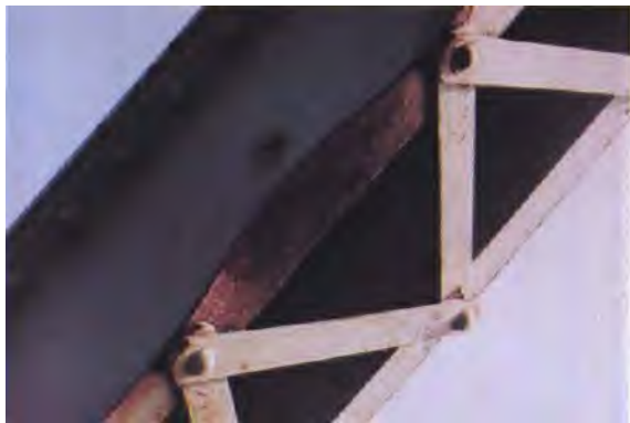
รูปที่ 3.3-4 การเสียรูปร่าง (Deformation) (ต่อ)
