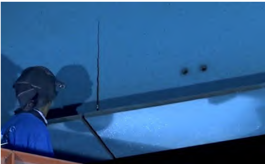
รูปที่ 1.1-2 คานตัวริมของสะพานที่ 3 (Flyover No.3) เกิดการรื้อขาด
