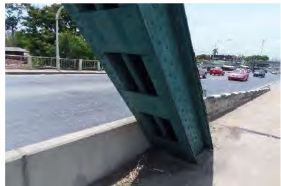
รูปที่ 3.3-1 ตัวอย่างการผุกร่อน (Corrosion)
