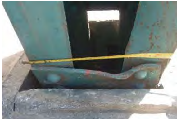
รูปที่ 3.3-4 การเสียรูปร่าง (Deformation)
