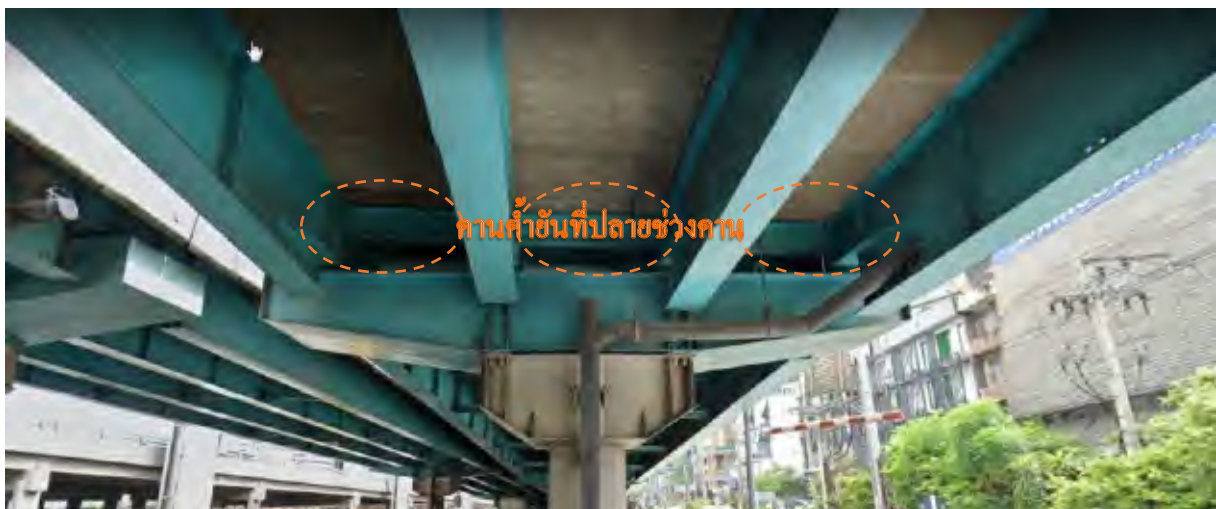
รูปที่ 10.2-3 ค้ำยันคานสะพาน
