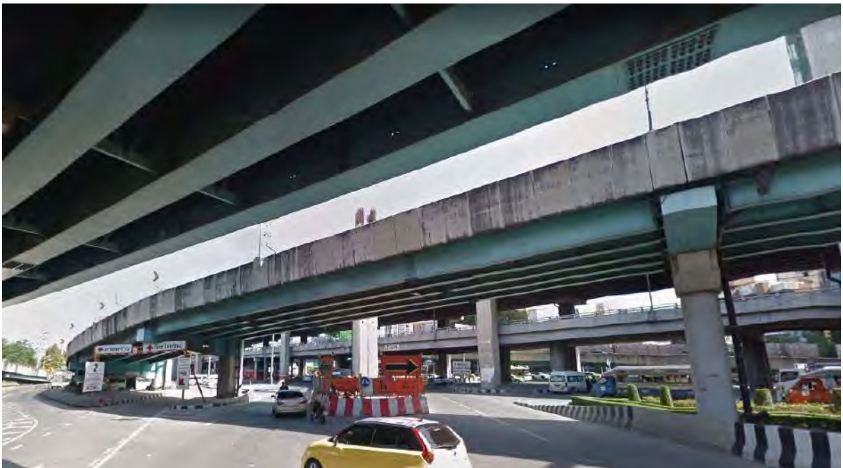
รูปที่ 5.1-2 สะพานตัวที่ 2 (Flyover 2) ช่วงสะพานที่ 9 (Span 9)
