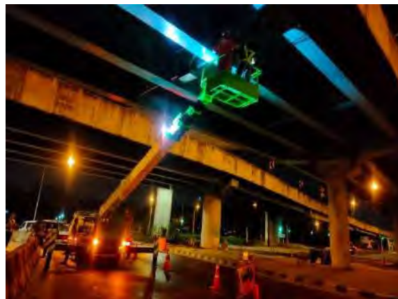
รูปที่ 4.1-12 การตรวจสอบความสมบูรณ์ของรอยเชื่อมด้วยวิธี Eddy Current
