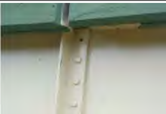
รูปที่ 3.3-3 ตัวอย่างความหลวม (Looseness)
