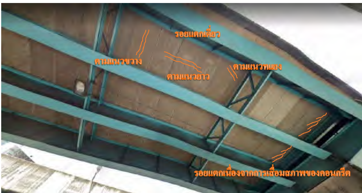
รูปที่ 10.3-1 ภาพจำลองรอยแตกเนื่องจากการเสื่อมสภาพของคอนกรีตและรอยแตกเดี่ยว
