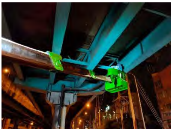
รูปที่ 4.3-8 การตรวจสอบความสมบูรณ์ของสลักเกลียวด้วยวิธี Torque Examination
