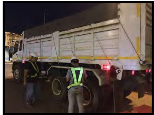
รูปที่ 5.8-4 ภาพการวัดมิติของรถบรรทุก
