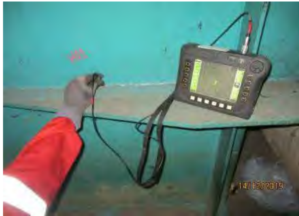
(ก) ตัวอย่างสะพานตัวที่ 1 ช่วงสะพานที่ 1
