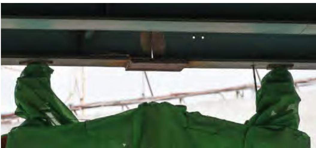
รูปที่ 1.1-3 การซ่อมแซมคานตัวริมที่รื้อขาดโดยใช้แผ่นเหล็กเชื่อมปะกับคานสะพาน
