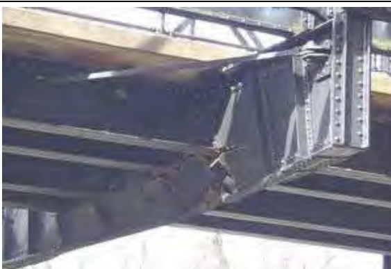
รูปที่ 3.3-2 ตัวอย่างรอยแตก (Cracking) (ต่อ)
