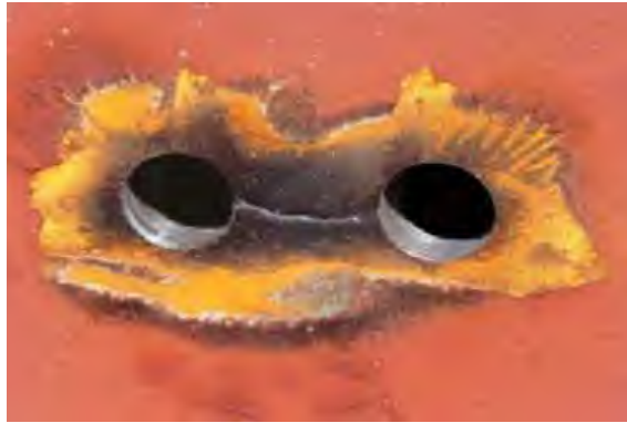
รูปที่ 3.3-2 ตัวอย่างรอยแตก (Cracking)
