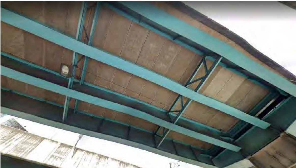
รูปที่ 10.2-1 พื้นสะพานคอนกรีตหล่อในที่เททับลงบนแผ่นพื้นสำเร็จรูป
