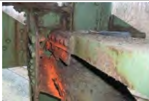
รูปที่ 3.3-3 ตัวอย่างความหลวม (Looseness) (ต่อ)
