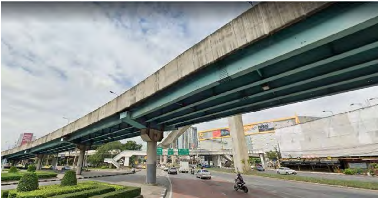
รูปที่ 10.1-2 คานเหล็กรูปตัวไอและตอม่อประเภทเสาเดี่ยวของสะพานเหล็กข้ามแยกลาดพร้าว
