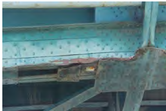
รูปที่ 3.3-4 การเสียรูปร่าง (Deformation) (ต่อ)
