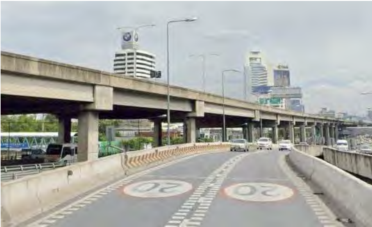
รูปที่ 10.2-8 ผิวจราจรแอสฟัลต์คอนกรีต
