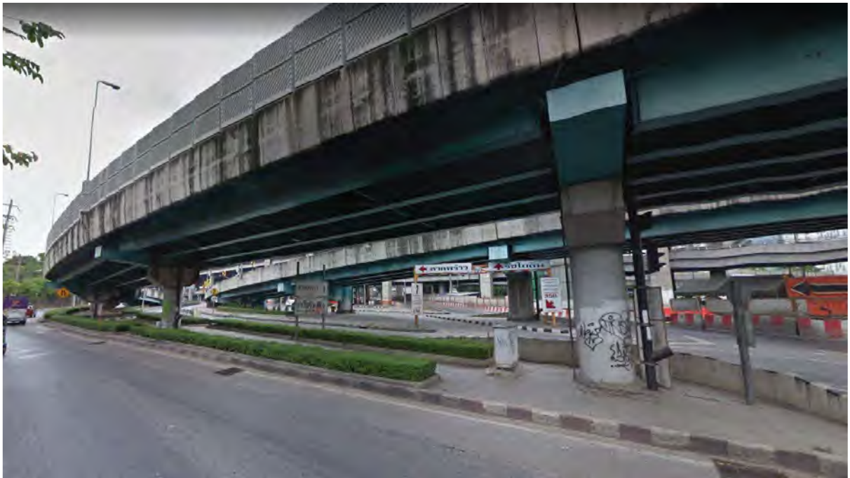
รูปที่ 5.1-1 สะพานตัวที่ 1 (Flyover 1) ช่วงสะพานที่ 9 (Span 9)
