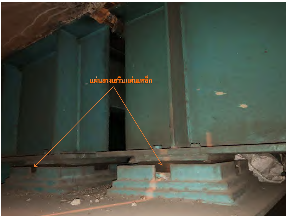
รูปที่ 10.2-6 แผ่นรองคานสะพานประเภทยางเสริมแผ่นเหล็ก
